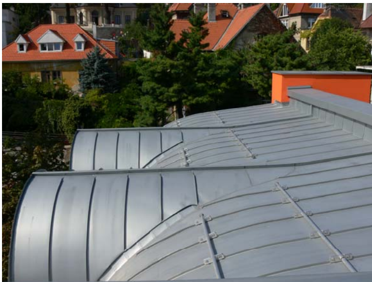
Nové zastrešenie systémom RHEINZINK
