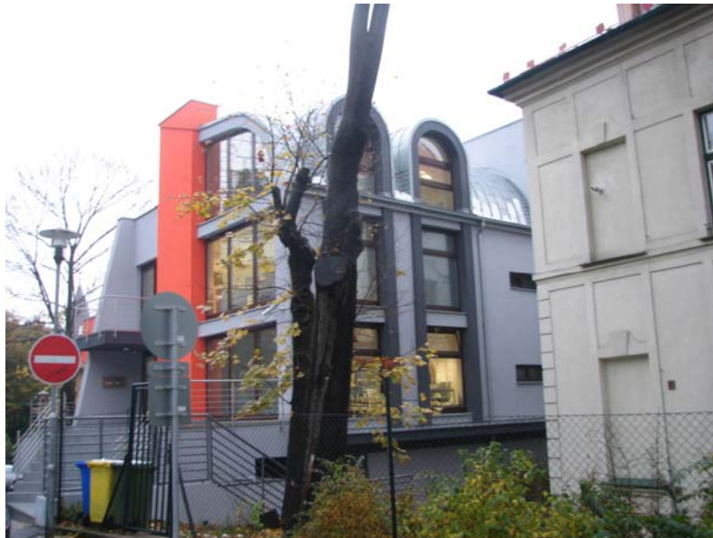
Pohľad na objekt zo Somolického ulici v Bratislave.
