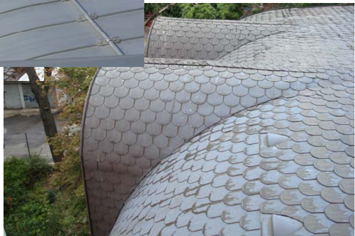
Pohľad na pôvodné zastrešenie.
